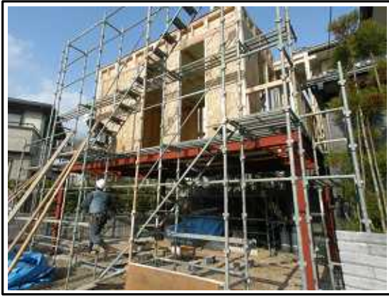
1Fが駐車スペース 2Fが寝室の増築工事です。
